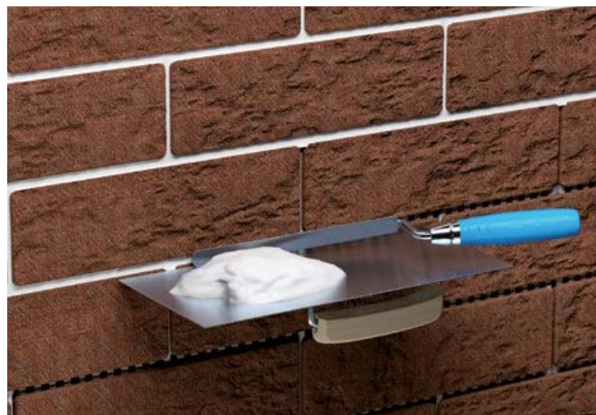
Attēls 4.69. Šuvju aizpildīšana ar šuvotāju Capatect Fugenmörtel
