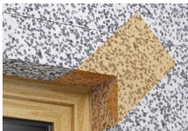
Attēls 4.37. Capatect-Sturzeckwinkel armēšanas veidgabalu montāža
