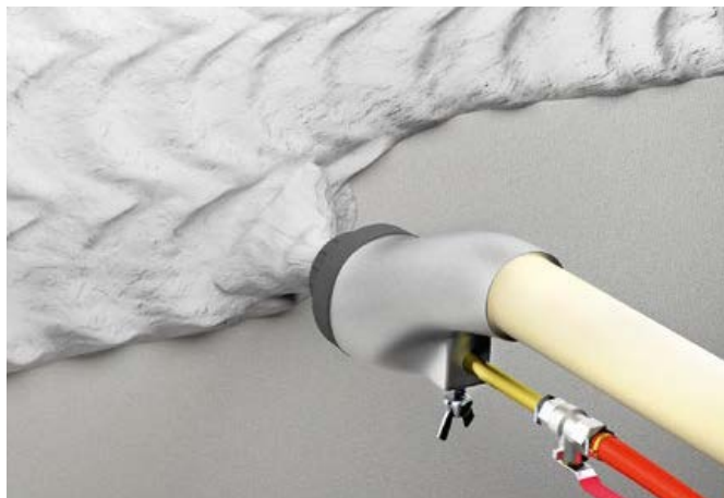
Attēls 4.58. Mehānizēta dekoratīvā apmetuma Capatect-Edelkratzputz K40 uzklāšana
