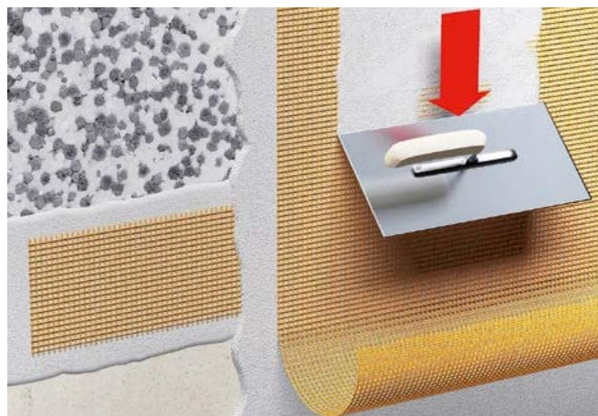
Attēls 5.13. Pāreju armēšana, pielietojot cokola aizsargplāksnes
