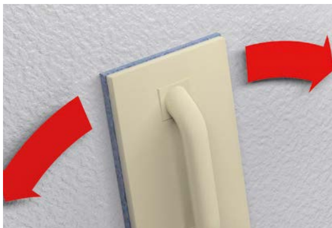
Attēls 4.57. Apmetuma filcēšana
