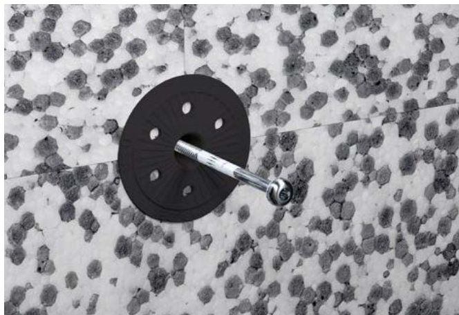
Attēls 4.28. STR Carbon montāža
