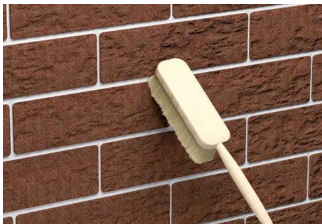
Attēls 4.68. Līmjavas pārpalikumu tīrīšana
