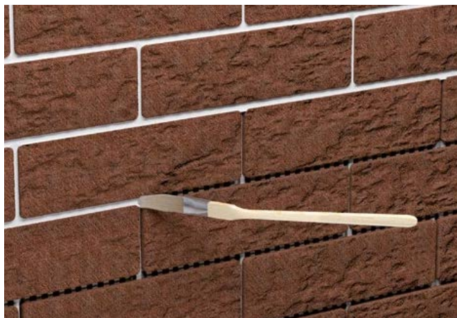
Attēls 4.67. Šuvju izlīdzināšana ar otu
