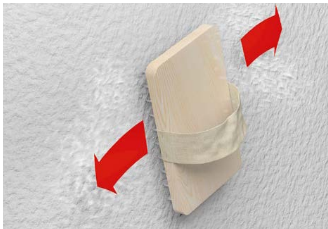
Attēls 4.59. Dekoratīvā apmetuma Capatect-Edelkratzputz K40 strukturēšana
