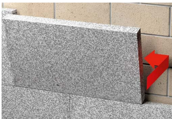
Attēls 4.17. Siltumizolācijas loksnes pielīmēšana
