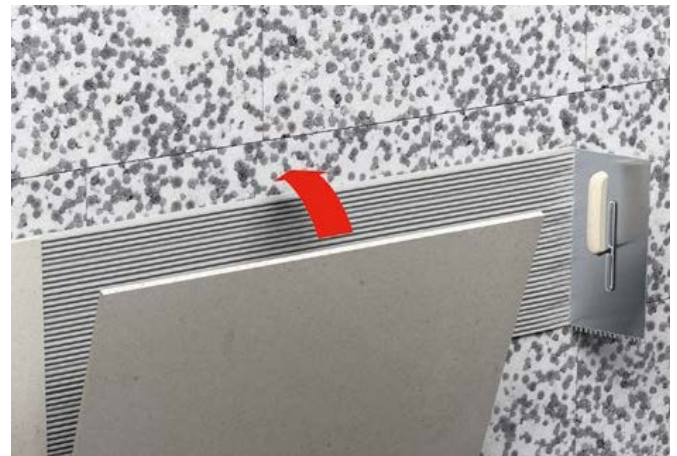
Attēls 5.8. Cokola aizsargplāksnes līmēšana
