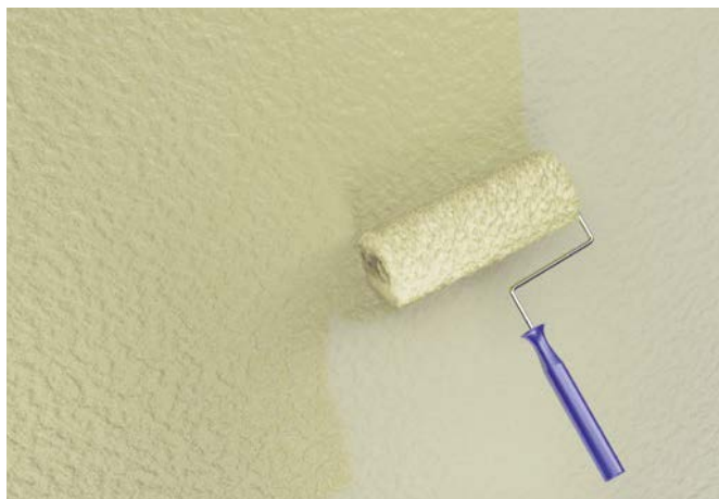
Attēls 4.53. Virsmas saķeres slāņa uzklāšana
