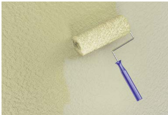
Attēls 4.61. Dekoratīvā struktūrapmetuma virsmas krāsošana
