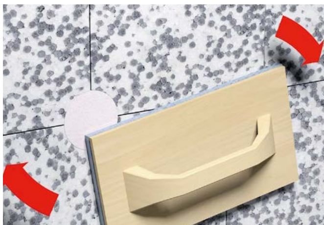
Attēls 11.6. Stiprinājuma uzstādīšanas vietas slīpēšana
