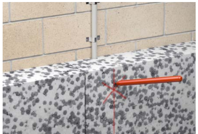
Attēls 4.25. Komunikāciju izvietojuma marķēšana
