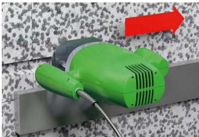
Attēls 8.9. Gropes iegriešana ar frēzi
